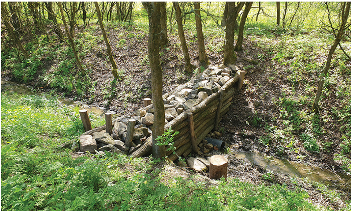
Dvojna pregrada iz hlodovine, ojačana s kamnom in geotekstilom. Foto: Krisztián Mészáros
