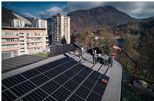
Na strehi Osnovne šole narodnega heroja Rajka je bila nameščena 300-kilovatna fotonapetostna elektrarna. Foto: Timotej Vrtnik/Focus
