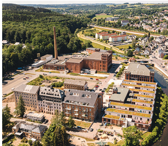
Bombažna predilnica po prenovi večine zgodovinskih stavb leta 2024. Foto: Mesto Flöha
