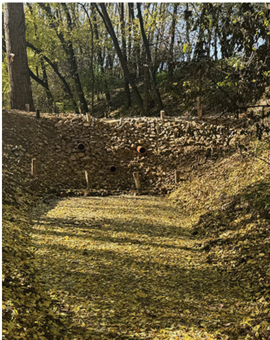
Jez za zadrževanje vode. Foto: Krisztián Mészáros
